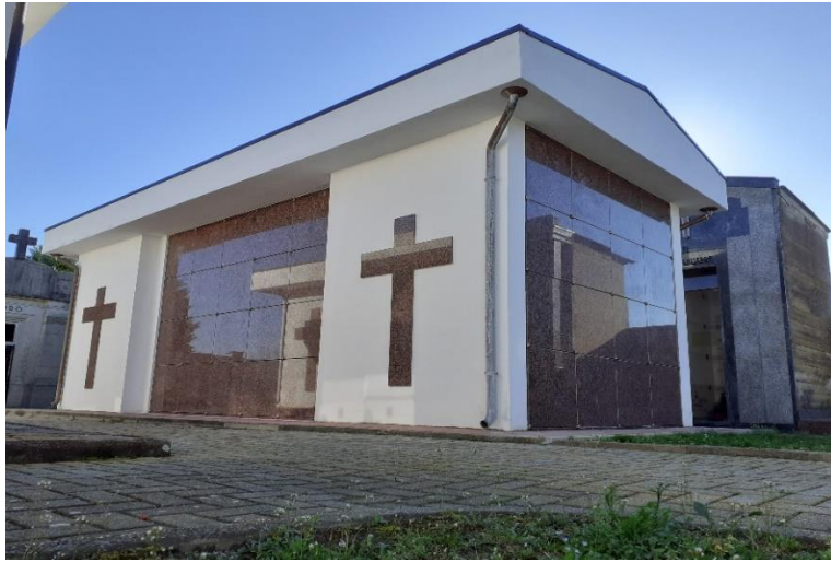
Nuovi loculi cimitero frazione Carrone
