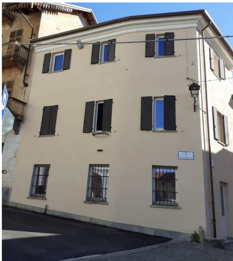
Biblioteca nuova - Vista dalla Piazza del Municipio
