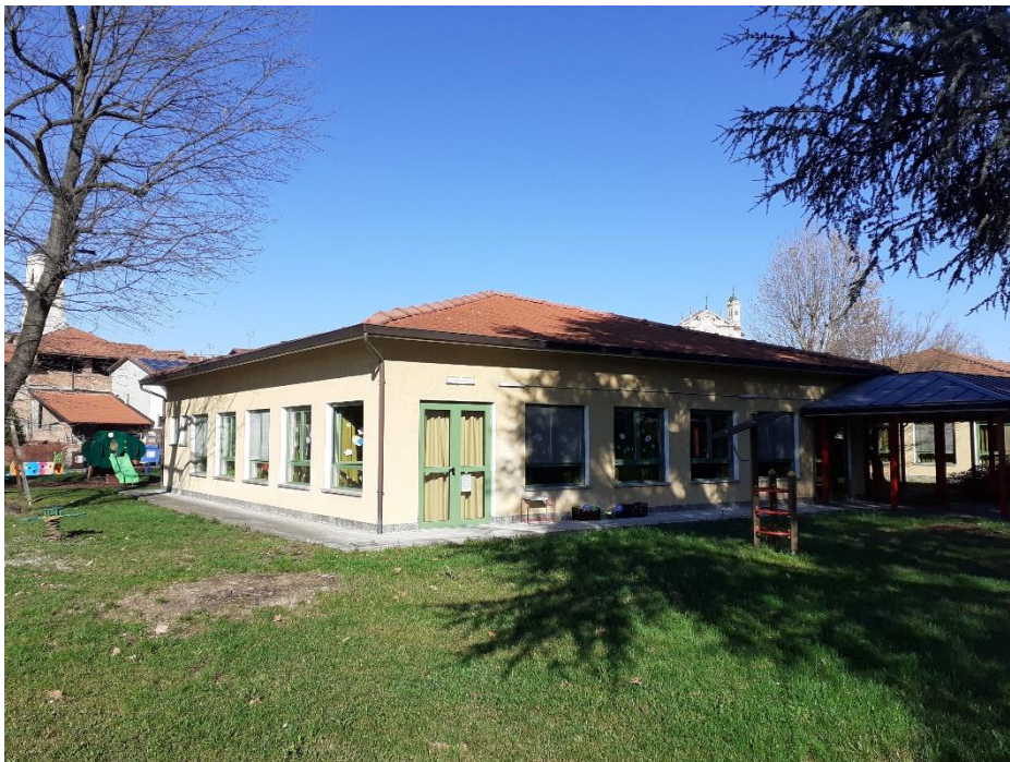
Sostituzione serramenti Asilo Nido - Scuola Infanzia Strambino
