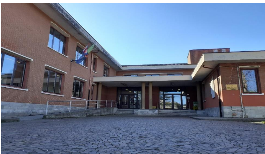
Sostituzione serramenti Scuola Media
