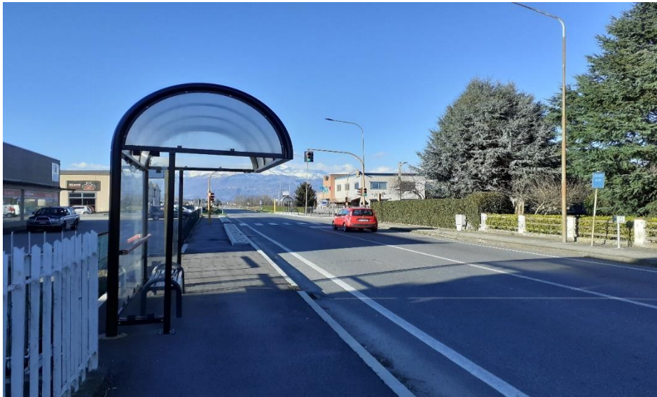
LAVORI DI RIPRISTINO E IMPLEMENTAZIONE MARCIAPIEDI STRADA STATALE 26
