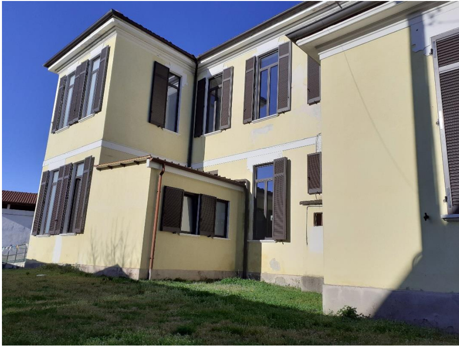
Sostituzione serramenti Scuola Infanzia frazione Crotte
